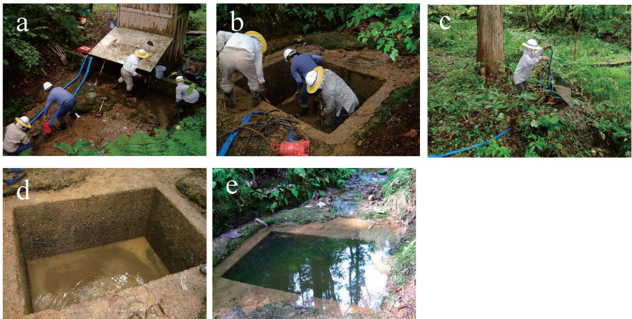
Photo 2. 1 号沢の沈砂槽における土砂浚渫
