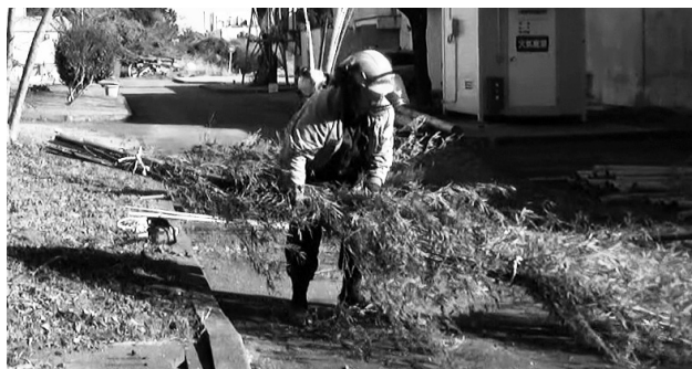
Photo 2. (β) 1 番玉 (枝なし) 1 本分と 2 番玉 (チェーンソーで枝を払い、その枝は使用せず) 1 本分の割竹と割らずにそのまま入れる先梢 (枝付き、枝払い無) 1 本による竹粗朶
