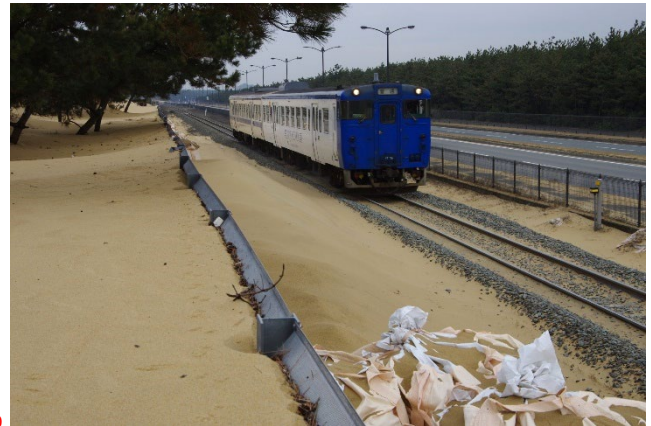
30 31 写真-2 福岡市東区 JR 香椎線海ノ中道駅付近 (2018年2月)
