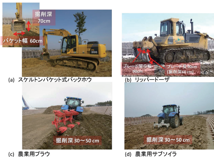
Fig. 3. 植栽基盤盛土の掻き起こしに用いた機械類 (写真提供: 仙台森林管理局) Machinery used for tikkages in berms.
