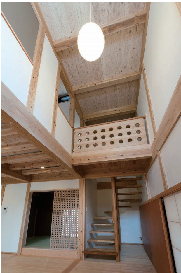
写真 4. 食堂居間から見た吹抜 Photo 4. A wellhole from the dining & living room.
