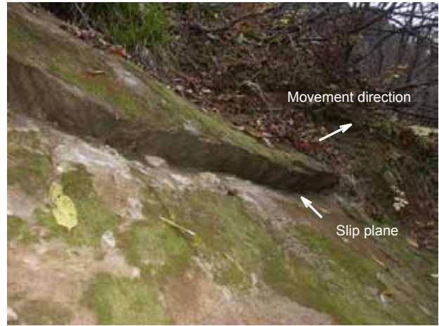
Photo 11. 溪岸の軟質岩（小野松沢層）中に見られるすべり面。傾斜角は水平面より上向きである。すべり面は侵食を受けていないことから地震時に生じたと考えられる。 Slip plane at the left bank of Ichihazama river appeared in the Onomatsuzawa stratum of lacustrine sediment. The dip of the plane rises toward to the stream. The movement occurred at the earthquake, because the slip plane is fresh, and not eroded.
