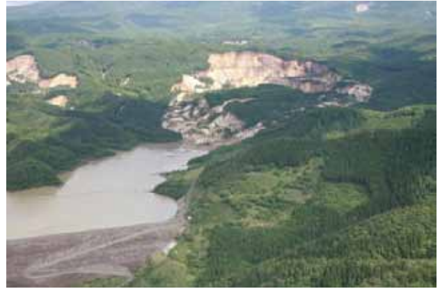
Photo 3. 荒砥沢地すべりと荒砥沢ダム。崩土のすべり方向は対岸の尾根に向かっている。これにより、ダム湖への突入・越流という最悪の事態は避けられた。 Aratozawa landslide and Aratozawa dam. A worst situation of debris thrust into the dam lake was avoided, because the landslide debris drifted toward the ridge of opposite bank.
