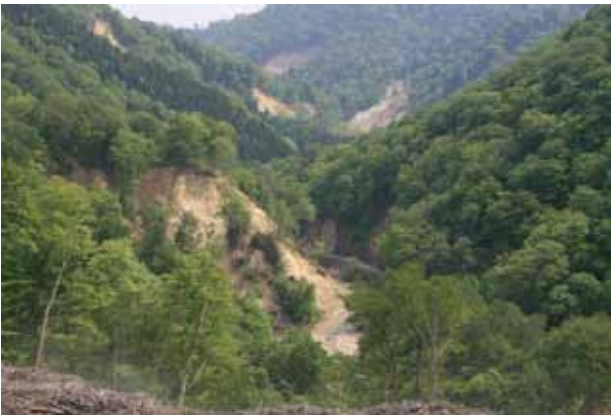
Photo 12. 一迫川支流原小屋沢の様子。無数の小規模の崩壊が発生している。 Devastation in the catchment of Harakoya tributary of Ichihazama river. Many landslides occurred along the stream.
