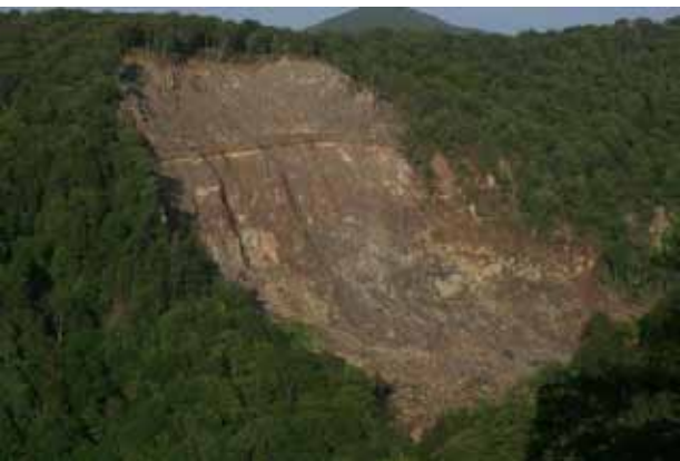
Photo 14. 湯浜峠対岸付近に発生した大規模崩壊（一迫川本流）。この崩壊によりやはり河道閉塞が発生した。溶結凝灰岩の層厚は上流の栗駒山に向かうにつれて厚くなっている。 A large landslide occurred at the left bank of Ichihazama river near the Yunohama pass. The landslide debris dammed up the Ichihazama river. The welded tuff becomes thicker in accordance with coming upstream to Mt. Kurikoma.
